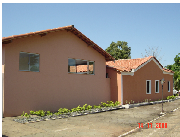
Vista externa da cozinha industrial e do centro de capacitação reformado
