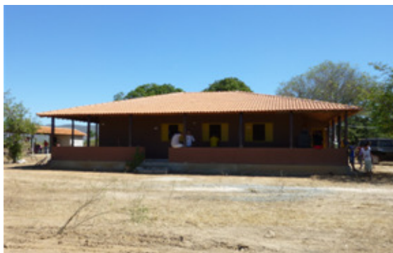
Centro Comunitário reformado
