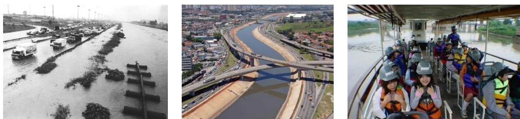
Fotos “Projeto rebaixamento da calha do Rio Tietê”
