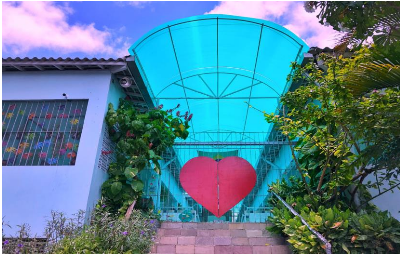
改修された屋根
