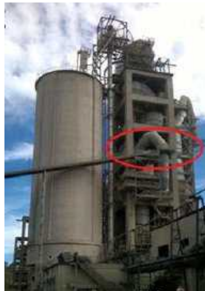
Forno de Cimento
