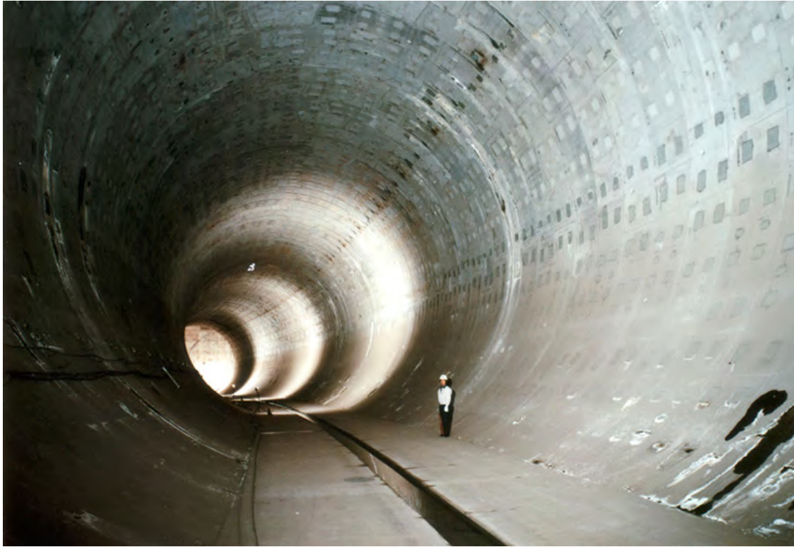
Interior do túnel. Ele retém até 540 mil toneladas de água.
