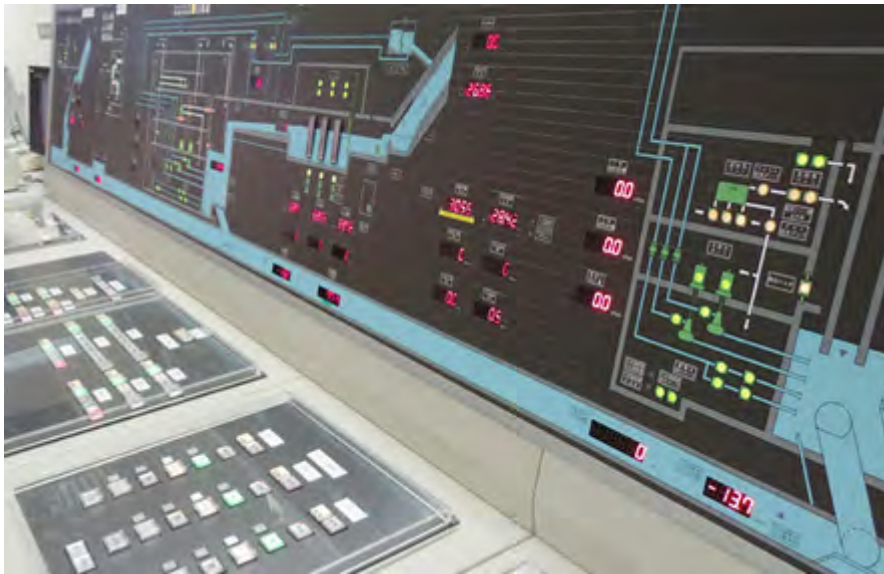
Painel central de controle da instalação de captação de água em Zenpuku-ji (ou, distrito Suginami, Tóquio). Três rios são monitorados e o sistema de captação e água é controlado de um único ponto.
