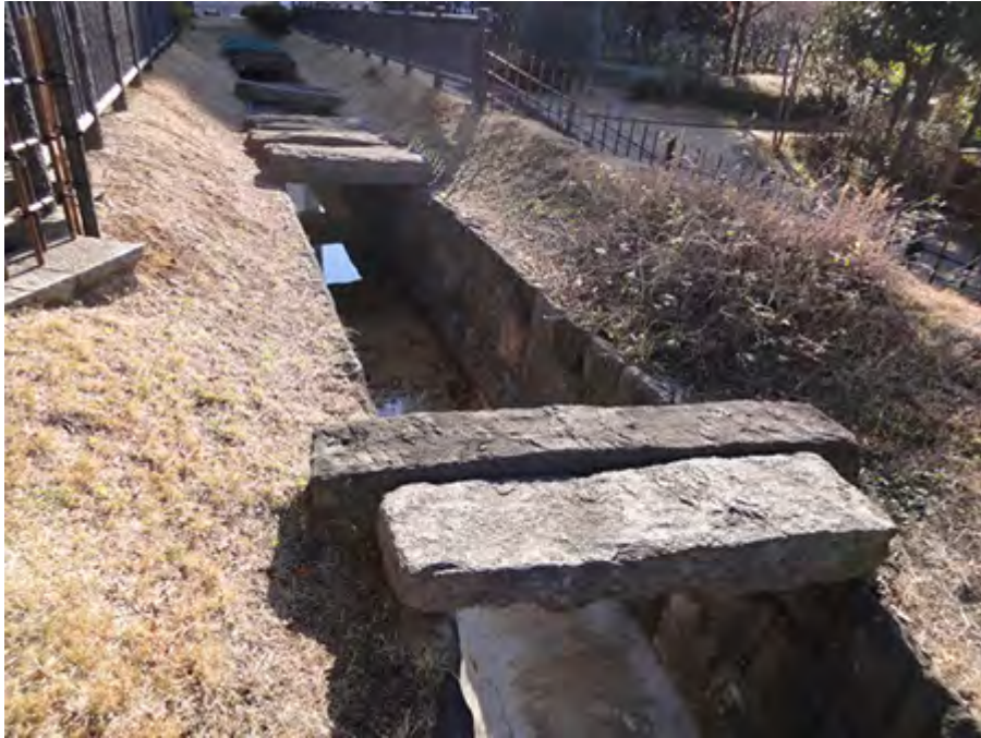
Canalização de pedra para transportar água de Kanda (realocado e restaurado). Era instalada no subsolo e usada para transportar água.
