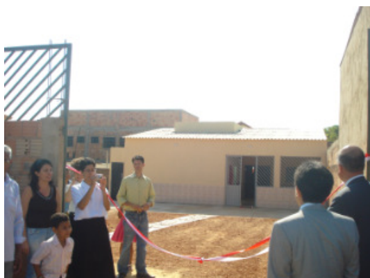
Vista externa da creche construída
