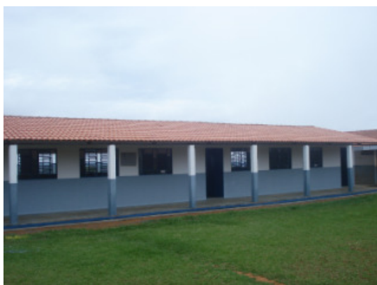
Salas de aula construídas
