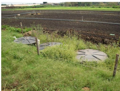
Fossa biodigestora instalada
