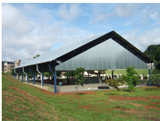
Vista externa da cobertura
