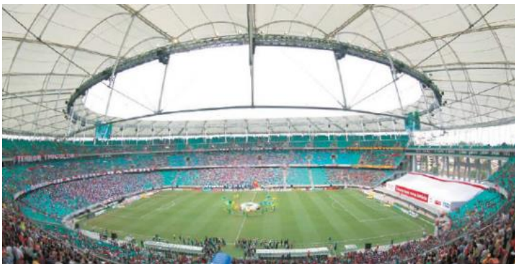
Circuito Internacional de Xangai (acima) e Arena Fonte Nova (ao lado) possuem telhados fabricado e instalados pela empresa Taiyo Kogyo. (Fotos cortesia da Taiyo Kogyo Corporation)
